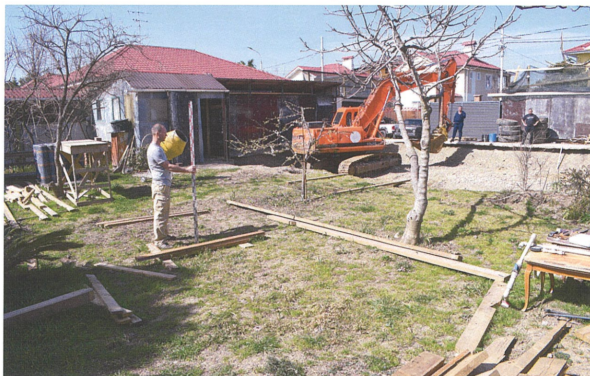
Илл. 14. З/у 23:49:0402061:2991. Обзорный вид с юго-востока.
