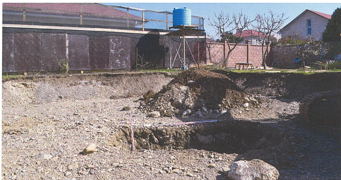
Илл. 18. З/у 23:49:0402061:2991. Шурф 1. Общий вид с запада.
