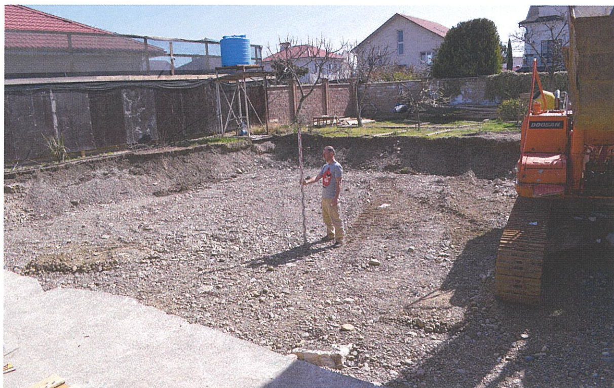
Илл. 12. З/у 23:49:0402061:2991. Центральная часть. Котлован. Вид с северо-запада.
