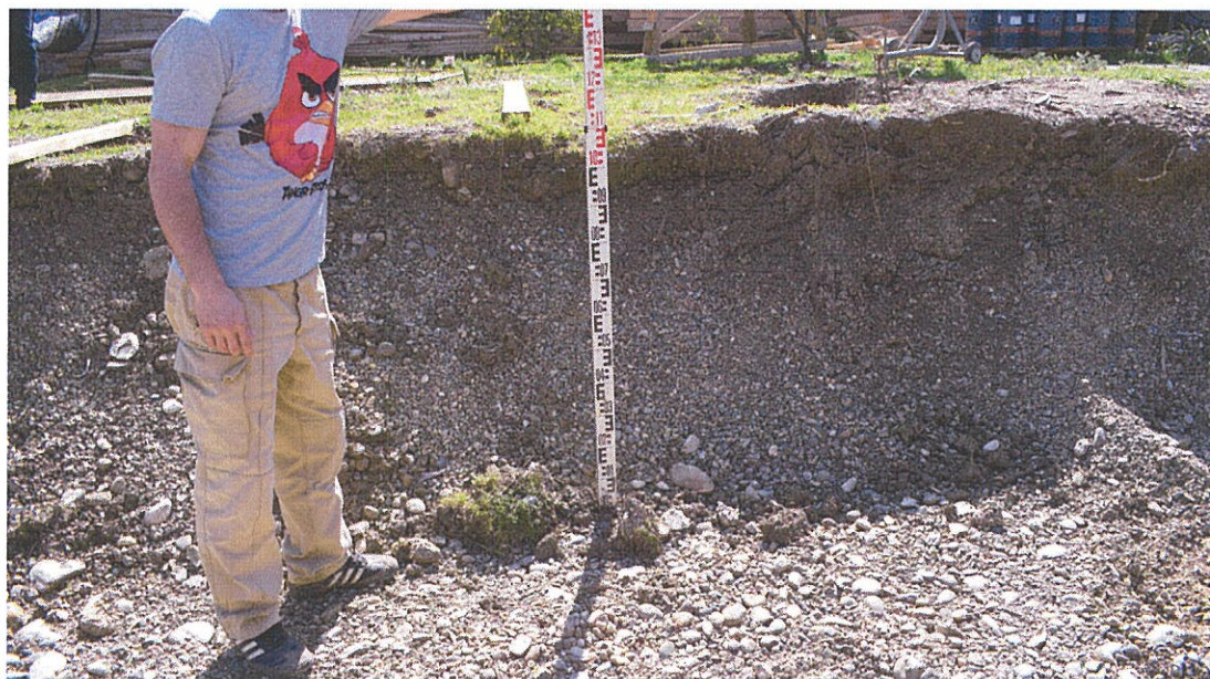
Илл. 16. З/у 23:49:0402061:2991. Борт котлована – насыпной грунт.
