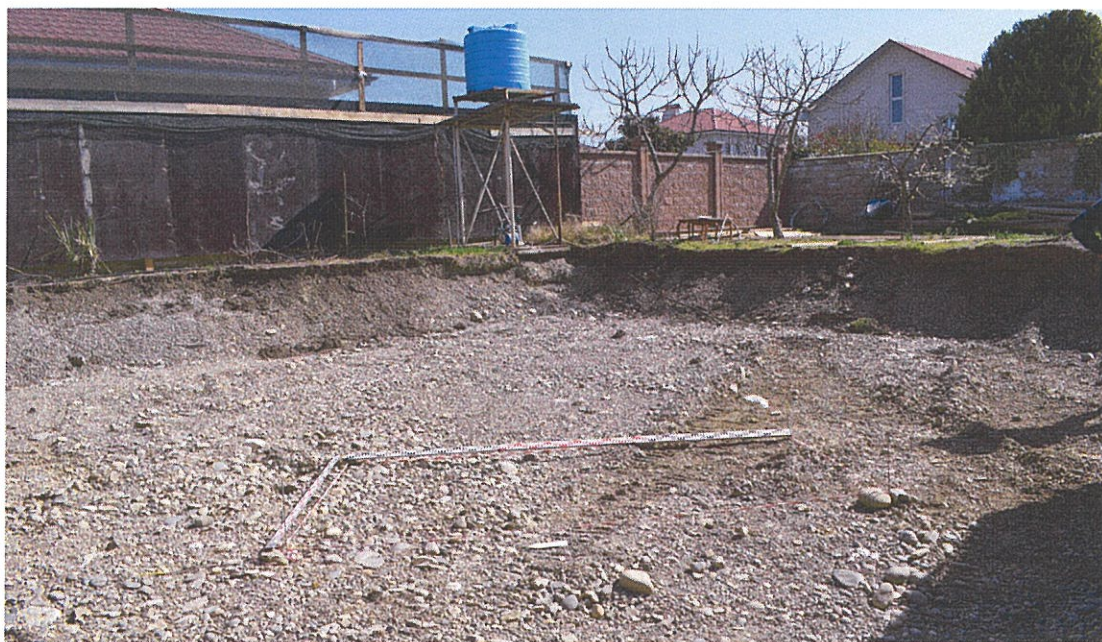
Илл. 17. З/у 23:49:0402061:2991. Шурф 1 до начала работ. Вид с запада.
