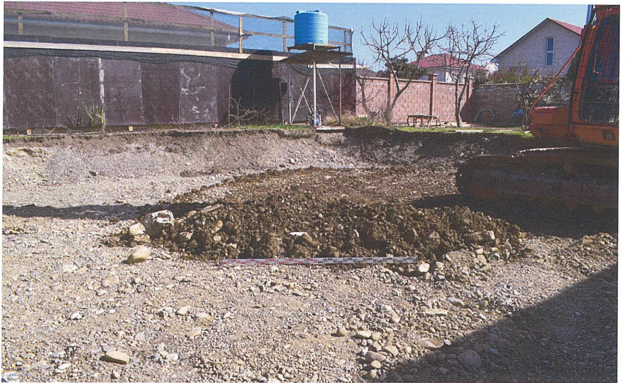
Илл. 23. 3/у 23:49:0402061:2991. Шурф 1. Вид после засыпки. Вид с запада.
