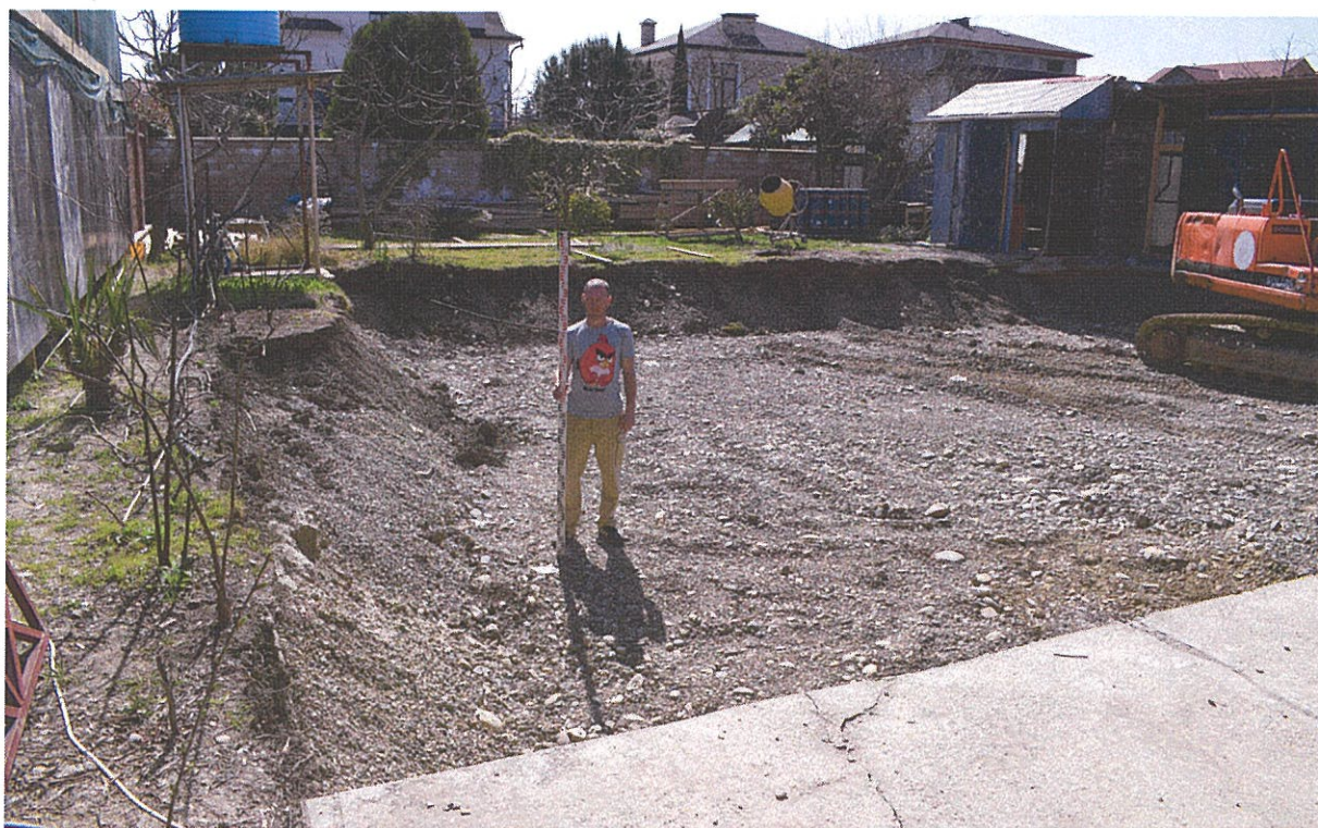
Илл. 11. З/у 23:49:0402061:2991. Центральная часть. Котлован. Вид с севера.
