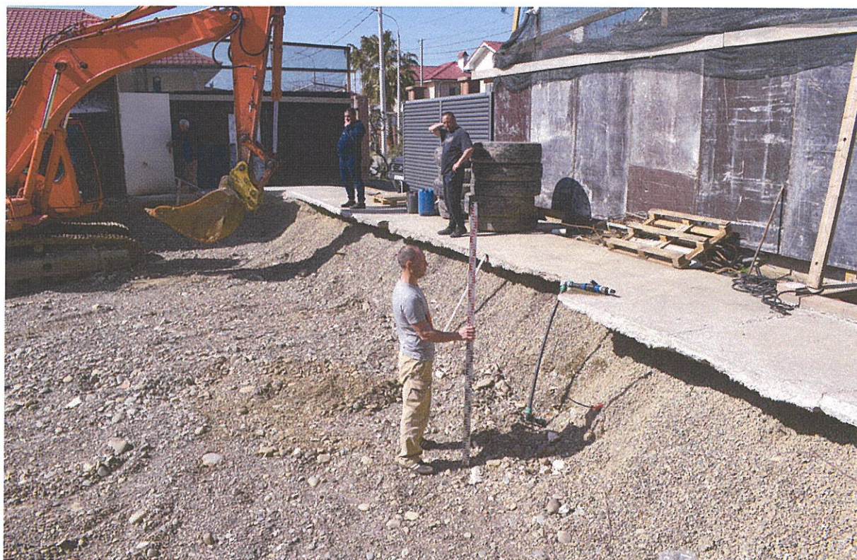
Илл. 13. З/у 23:49:0402061:2991. Северная часть. Котлован. Вид с востока.
